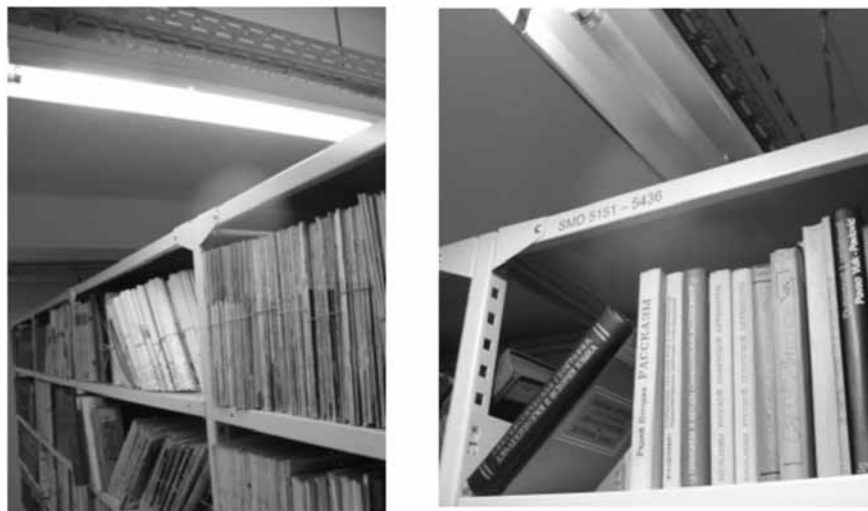
Slika 3 in 4: Električna napeljava (osvetljava) povsem blizu polic
