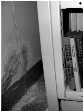
Slika 14: Vdor vlage ob zidni razpoki
